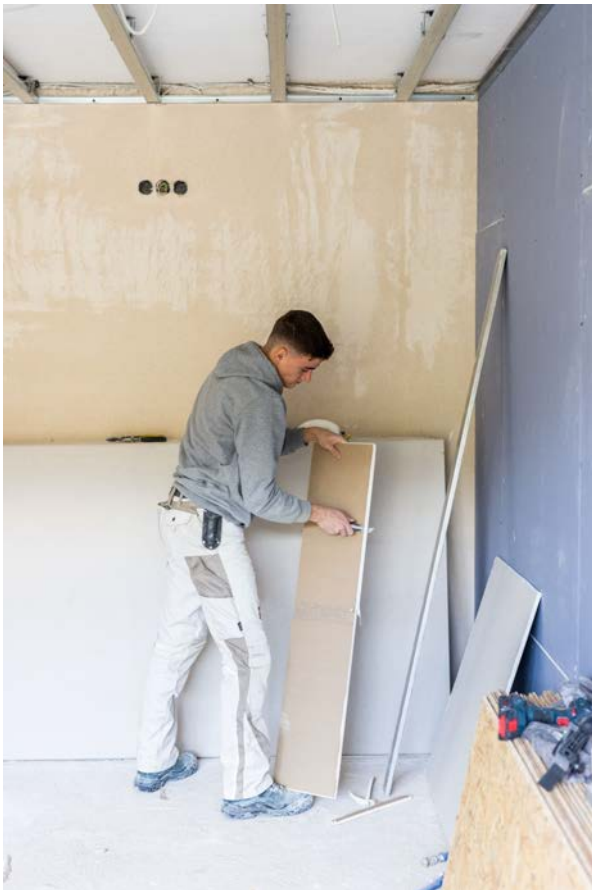
Die Arbeit von Stuckateuren fordert auch korperlich. Azubi Jonas Schwarzwalder schneidet ein Trockenbauelement zu. Philipp von Ditfurth/dpa-tmn
