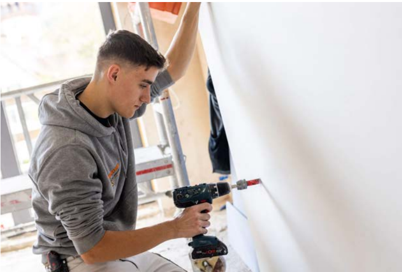
Jonas Schwarzwalder hat einen abwechslungsreichen Berufsalltag. Hier bohrt er ein Loch in eine Gipskartonplatte-Platte. Philipp von Ditfurth/dpa-tmn
